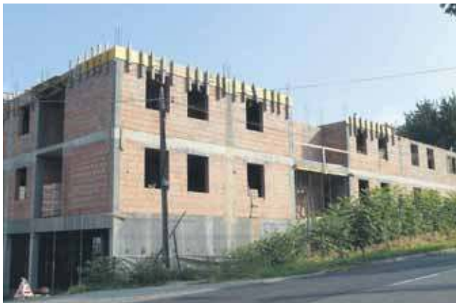
Budowa budynku mieszkalnego wielorodzinnego przy ul. Wyżyńskiego
