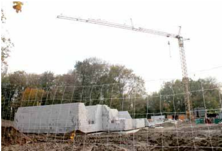
W budowanym obecnie przez STBS budynku przy ul. Śniadeckiego we wrześniu przyszłego roku planowane jest otwarcie żłobka dla 48 dzieci
