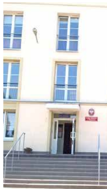
Teren wokół Bursy Szkolnej zostanie zagospodarowany. Powstanie również ogrodzenie oraz bramka umożliwiająca dojście do Poradni
