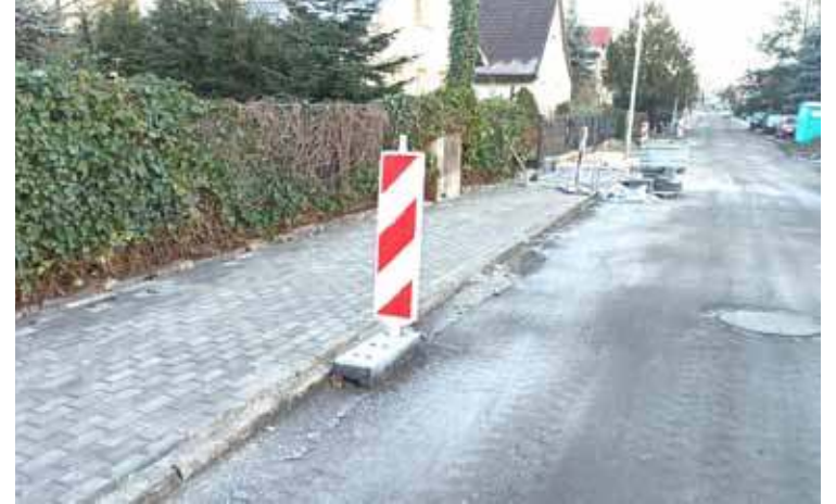
Nowa nawierzchnia z kostki betonowej zostanie zbudowana wzdłuż całej ulicy K. Szymanowskiego
