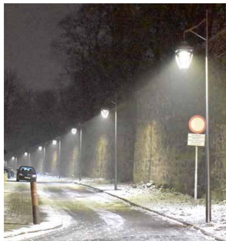
Na ulicy Warownej zamontowano 21 lamp ledowych
