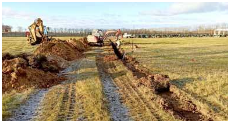
Na Nowym Cmentarzu rozpoczęła się budowa nowej alejki
