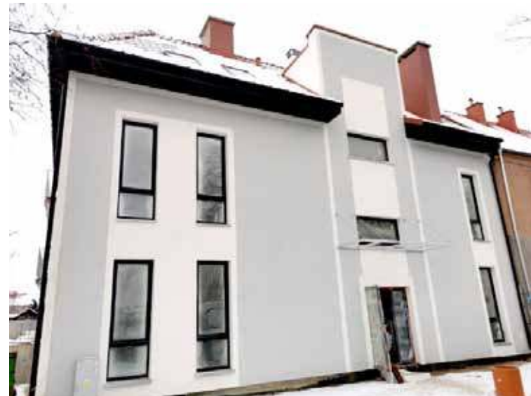
W budynku przy Kościuszki powstanie 14 mieszkań i podziemny garaż
