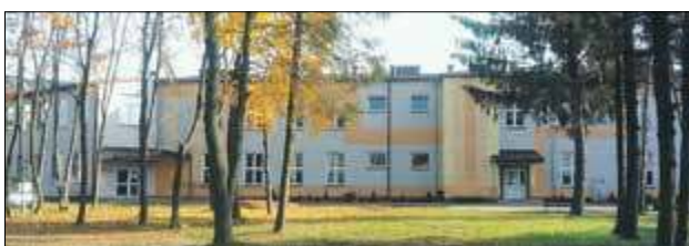
Rewitalizację przejdzie obszar Zespołu Szkolno-Przedszkolnego w Tuczy, gdzie zamontowane zostanie m.in. oświetlenie
