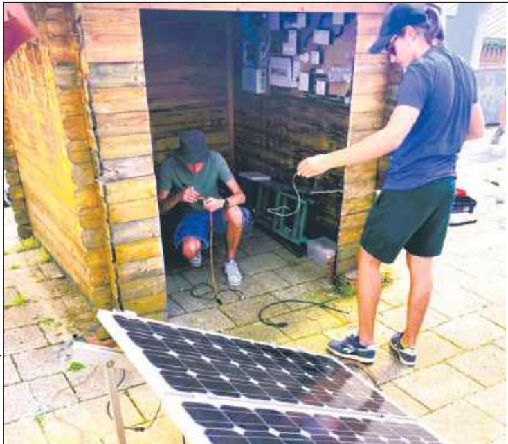
Elektrycy podczas budowy domu solarnego w Sewilli
