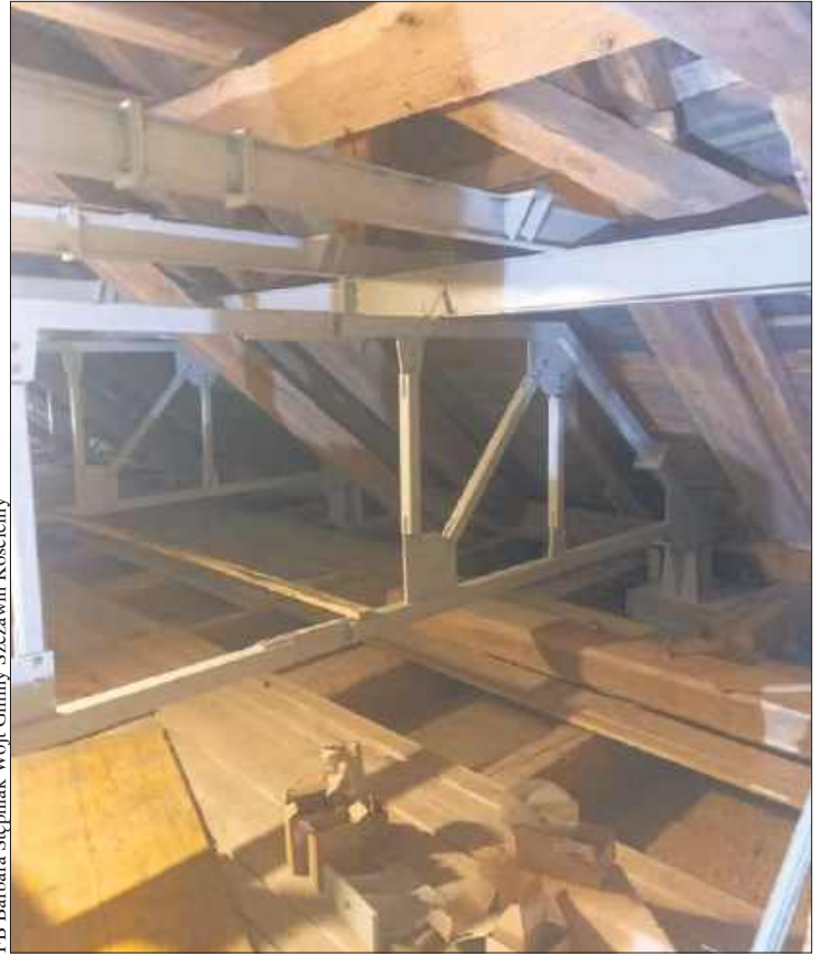
Remont w kościele w Suserzu
