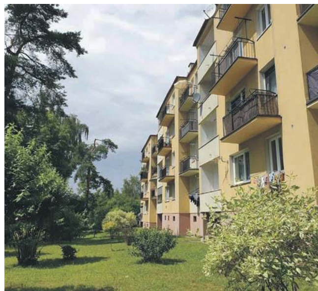
Za blokiem przystrojony trawnik oraz ładne krzewy
