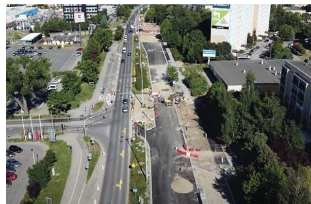
Ul. Pstrowskiego w trakcie remontu w 2023 roku
