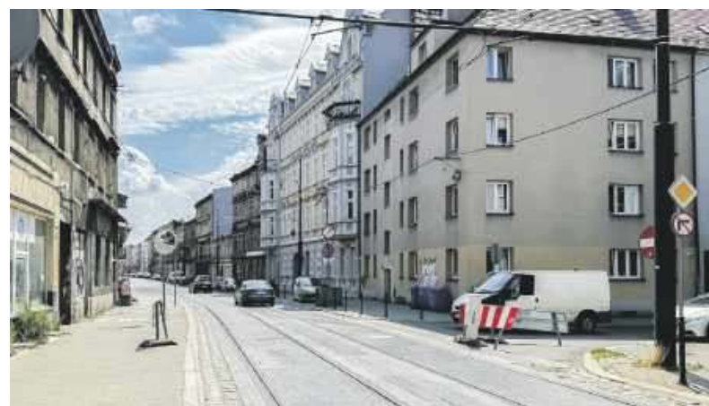
Kierowcy nie mogą doczekać się końca prac na Katowickiej
