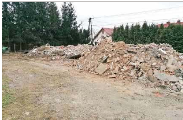
Budynek starego przedszkola zlokalizowany był w centrum Nagoszyna.
