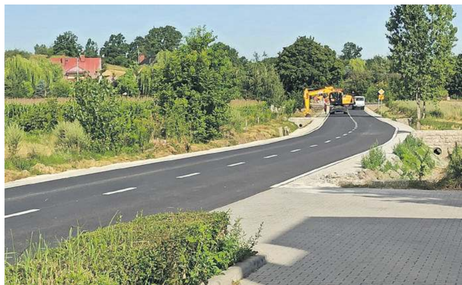
Przebudowano i poszerzono drogę, namalowano także pasy
