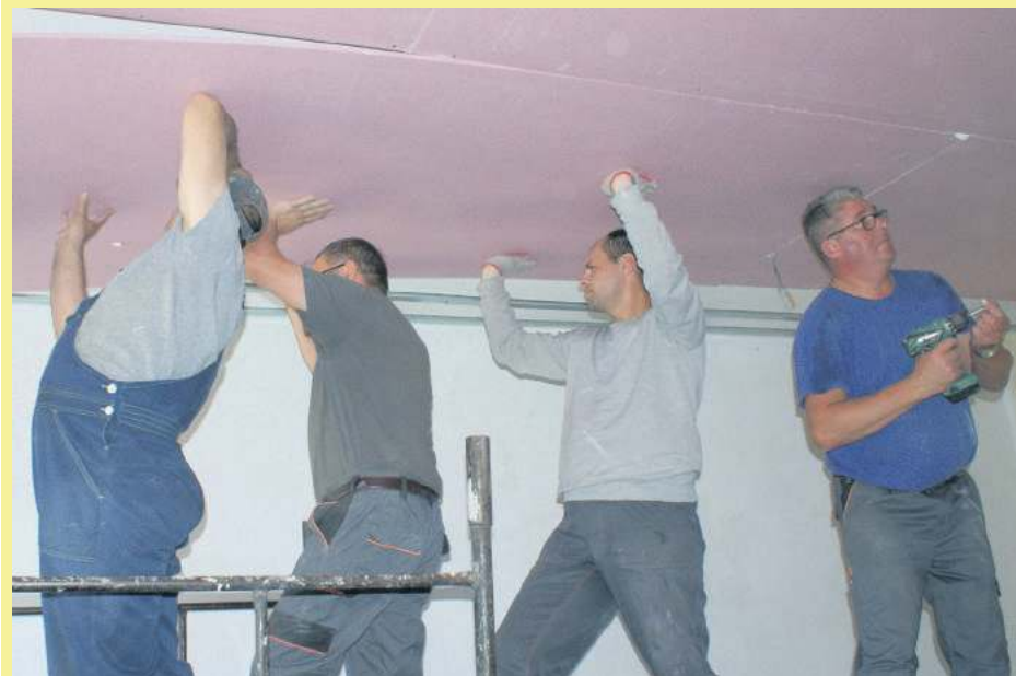
Montaż płyt sufitowych wymaga nie lada zręczności
