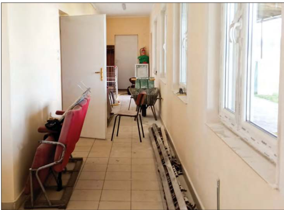
■ Ostatnio prace koncentrowały się na korytarzu budynku klubowego. Pracownicy ZGK zajęli się obróbką okien i tynkami
