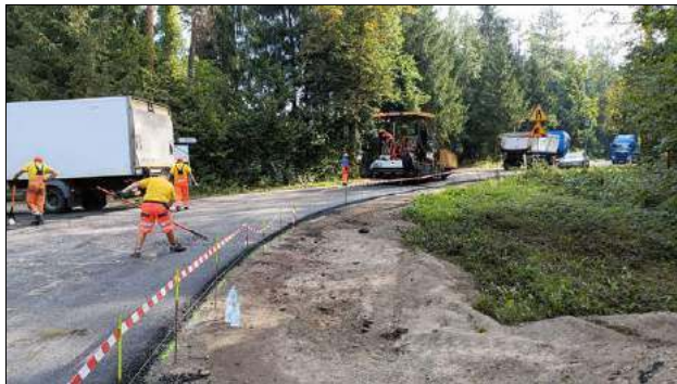
Trwają roboty drogowe na trasach numer 2007W i 2008W
