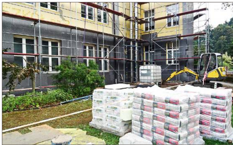
Ściany zewnętrzne Zespołu Szkół nr 2 w Dębicy są docieplane.
