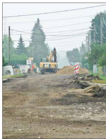
Na odcinku Mościckiego w kierunku Metalowców prace wciąż trwają.
