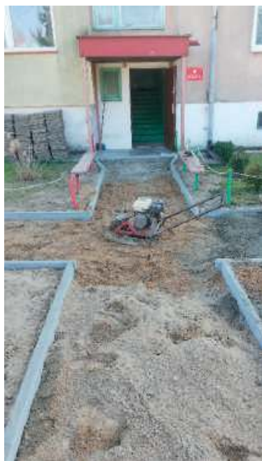
Przebudowa chodników w msc. Kalinka
