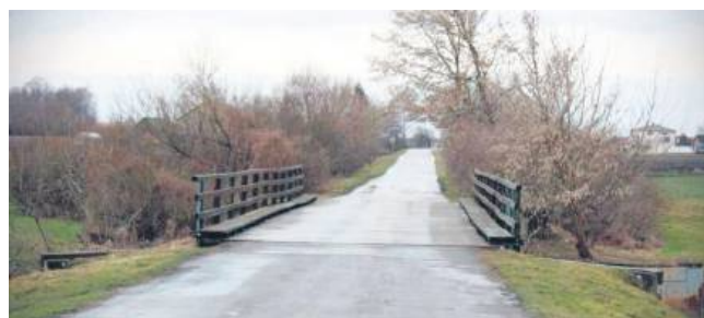
Przebudowa mostu w Brodnicy powinna potrwać do połowy grudnia tego roku.
