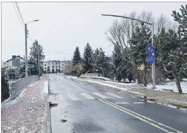
Jednym z najważniejszych remontów w opinii samorządu była przebudowa mostu na rzece Zielawie, łączącego Wisznice z Wygodą
