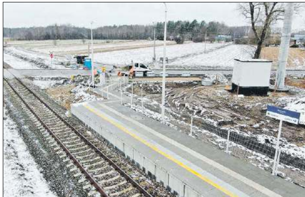
Przystanki modernizowane są w ramach „Rządowego programu budowy lub modernizacji przystanków kolejowych na lata 2021-2025”. Na zdj. przystanek w Aleksandrowie
