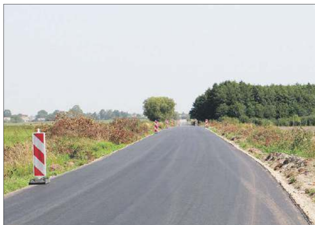
W trakcie ostatniej kadencji wybudowano, przebudowano i wyremontowano wiele odcinków dróg. Na zdjęciu droga Horodyszcz-Lyniew
