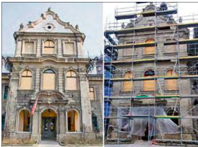
Elewacja czyszczona jest techniką piaskowania na sucho.
