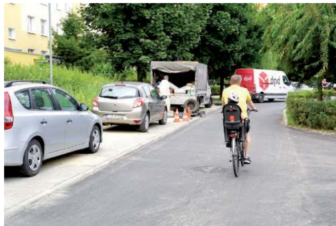
Wiklinowa już przejezdna. Remont ulicy kosztował 647 tys. zł
