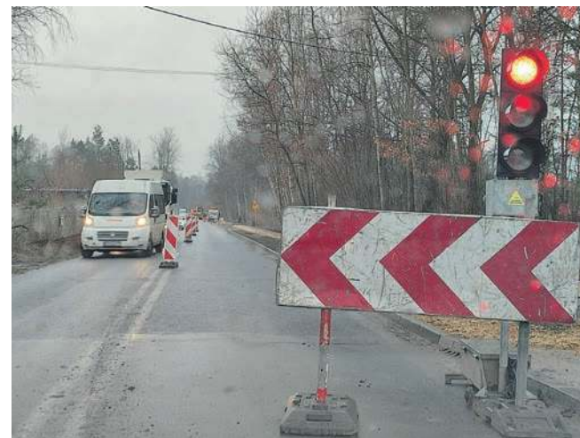
Aktualnie obowiązuje ruch wahadłowy na leśnym odcinku ul. Słowackiego w Trzebinii
