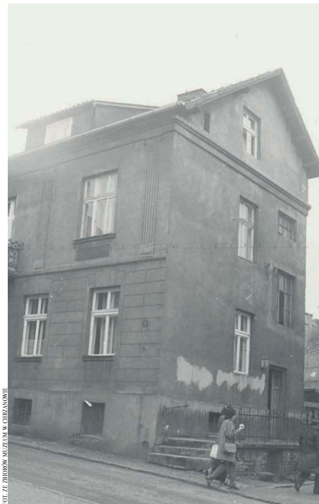
Kamienica przy Sądowej 6 w Chrzanowie, naprzeciwko małego parkingu
