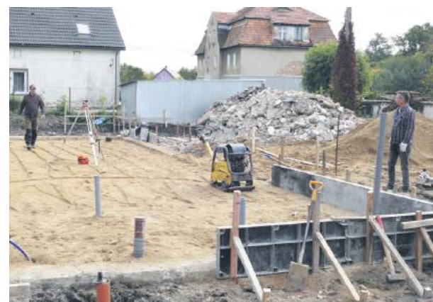
Budową nowej świetlicy i rozbiórką wcześniejszej zajmuje się firma Ciepły Dom z Karnkowa
