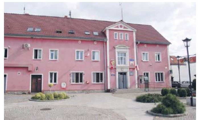
Na budynku Urzędu Gminy w Kondratowicach zostanie zamontowana instalacja fotowoltaiczna za 150 tys. zł
