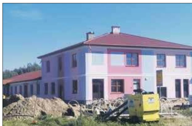
W Curyńie trwają intensywne prace remontowe. Rozpoczęcie funkcjonowania ZOL-u planowane jest na drugi kwartał 2021 r.
