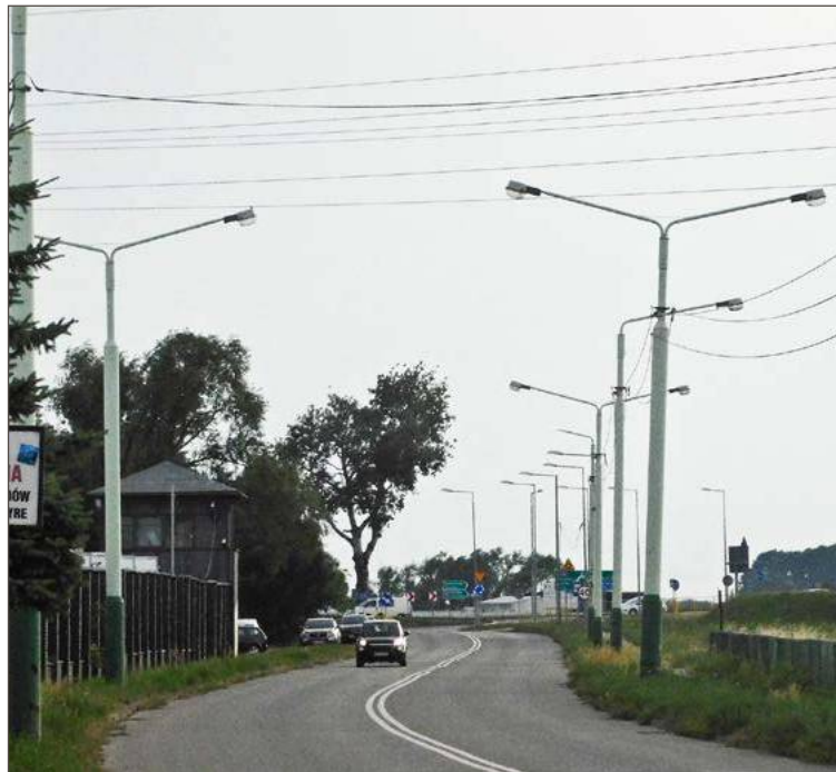
Stare lampy zastąpią nowe, energooszczędne w technice LED.
