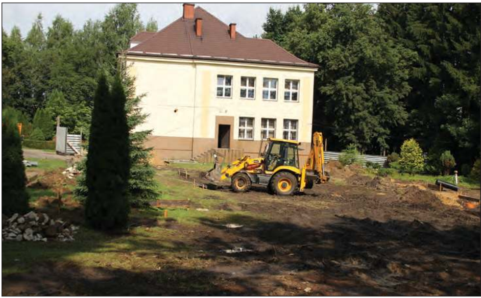
6 lipca ruszyła budowa sali gimnastycznej przy szkole w Moszczance. Jeżeli wszystko pójdzie zgodnie z planem, powinna być gotowa w sierpniu przyszłego roku
