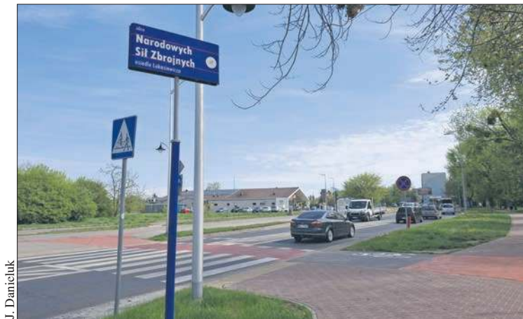
Ulica Narodowych Sił Zbrojnych wymaga remontu
