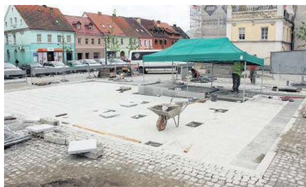
Pod powierzchnią fontanny wykonano już instalacje technologiczne i położono płyty betonowe pod kaskady
