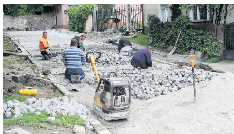
W ubiegłym tygodniu pracownicy kładli nawierzchnię z kostki
