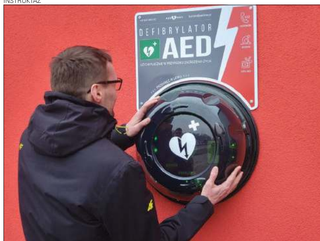
Radny Jakub Elsner pokazuje, że aby wyjąć defibrylator należy przekręcić pokrywę, zgodnie ze strzałkami
