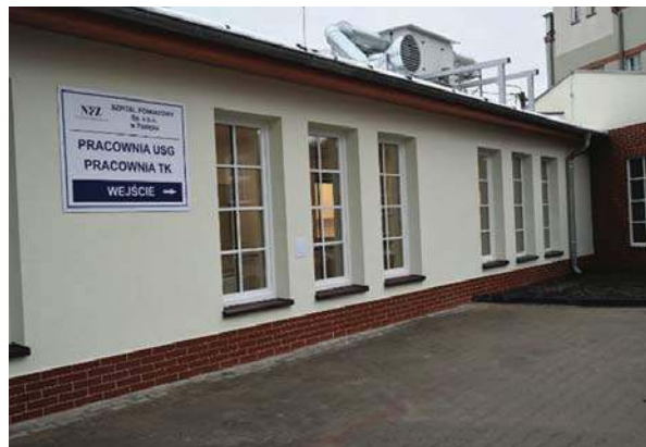
Budynek Pracowni TK
