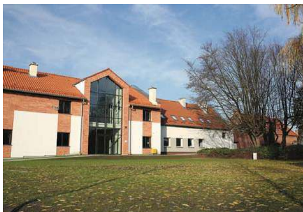
Remont budynków LSP
