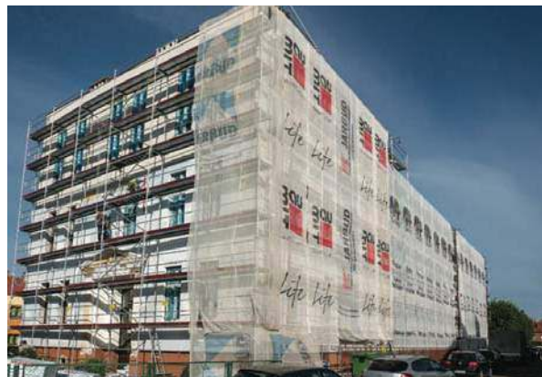
Termomodernizacja w ZS
