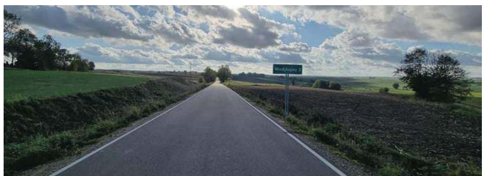
Droga w miejscowości Windykajmy po przebudowie
