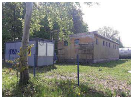
Stacja Uzdatniania Wody w Nowej Różance przed przebudową
