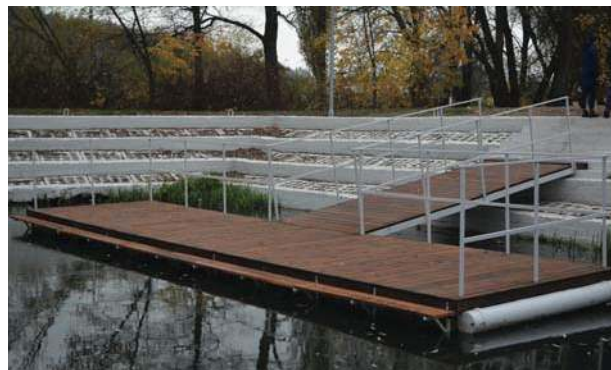
Przystań kajakowa po modernizacji
