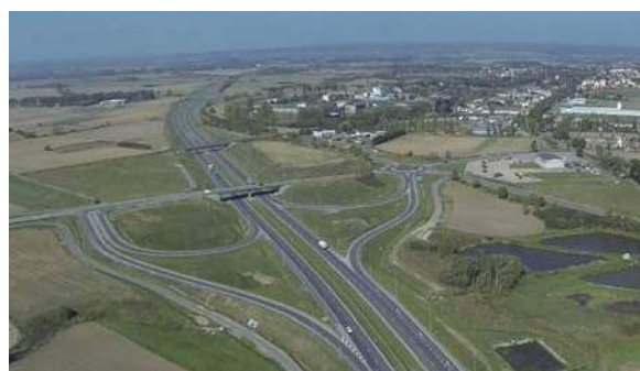
Droga S7 – Węzeł Pasłęk Południe
