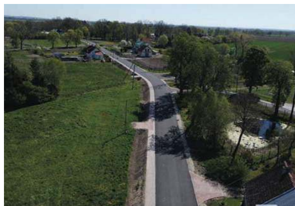
Remont drogi w Fiszwie
