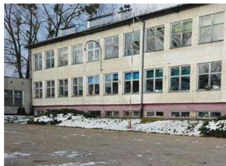
Szkoła Podstawowa w Nakomiadach przed termomodernizacją
