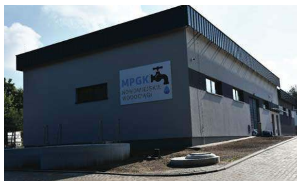
Nowa stacja uzdatniania wody
