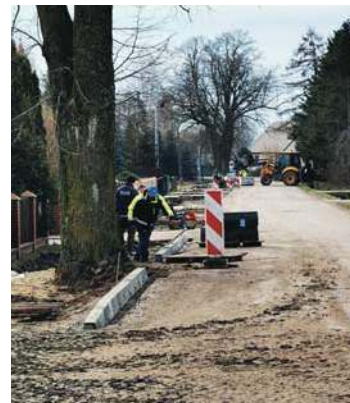
Przebudowa chodnika Wielki Łęck
