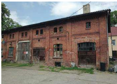
Remiza w Karolewie przed przebudową
