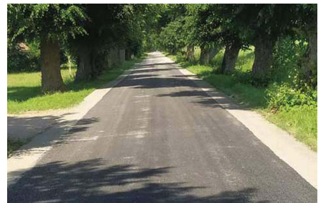
Wyremontowana droga powiatowa
