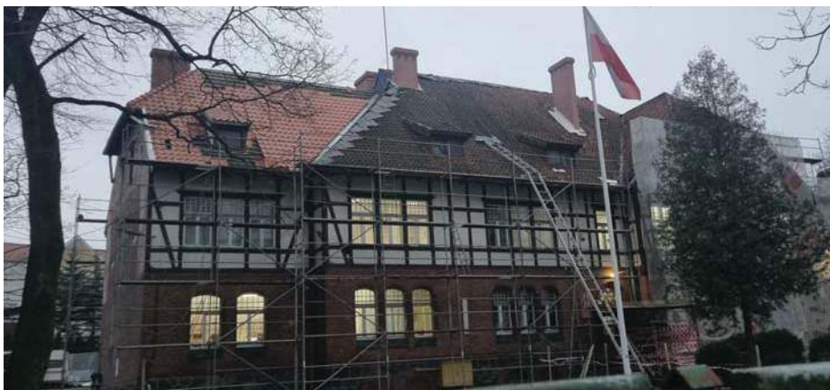
Budynek Urzędu Gminy Kętrzyn w trakcie termomodernizacji
