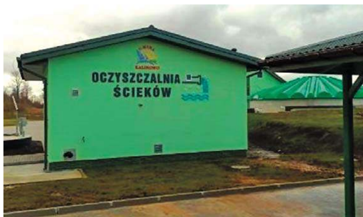
OCZYSZCZALNIA ŚCIEKÓW W KALINOWIE
