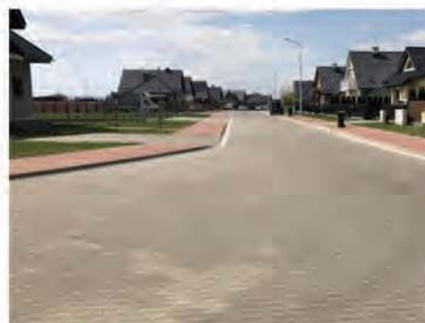
Mieszkańcy ulicy Jaśminowej czekali kilkanaście lat na budowę drogi.
