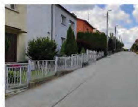
Ulica Reymonta nie straszy już dziurami w nawierzchni.
