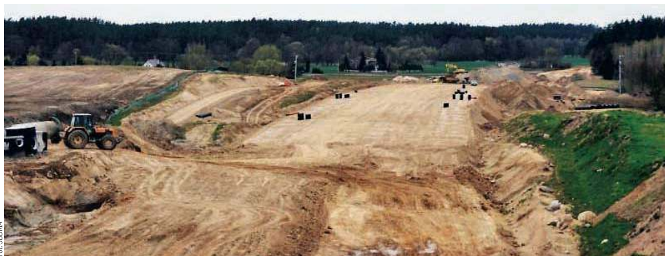
Obecnie trwa budowa pierwszego odcinka przyszłej trasy S5 Ornowo-Wirwajdy
