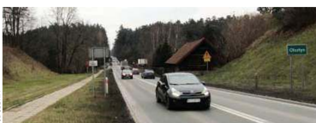
Budowa północnej obwodnicy Olsztyna zakłada też przebudowę drogi 51 przez Las Miejski
