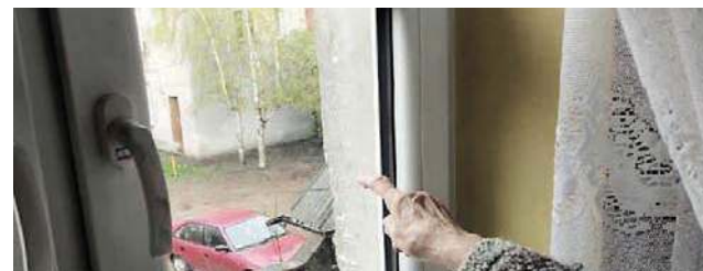
Kamienicę przy Warmińskiej 6A dzieli od centralnego ogrzewania 9,5 m
