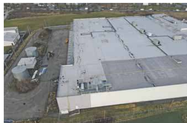
Budynek ma zostać powiększony o dodatkowe skrzydło
