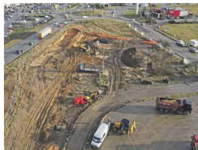
W rejonie ronda trwają roboty ziemne
