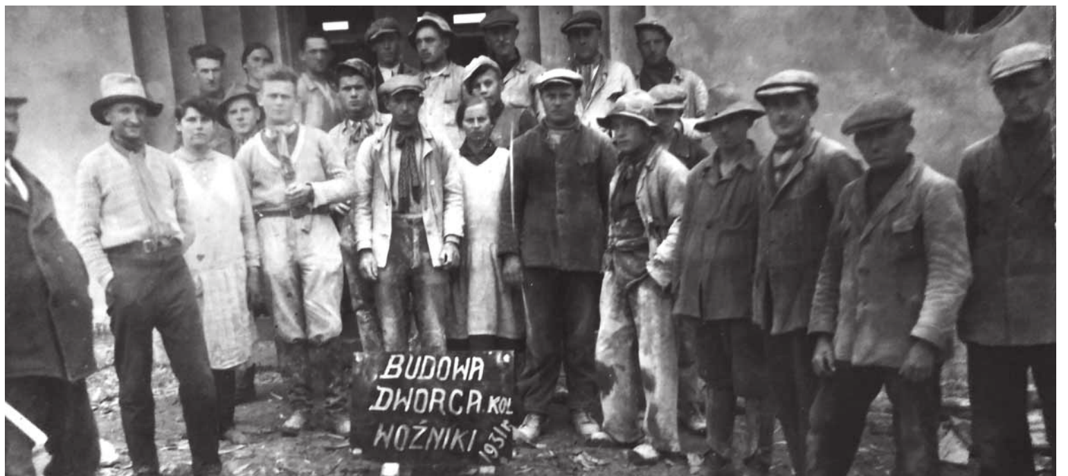
Rok 1931, czas budowy dworca kolejowego w Woźnikach
