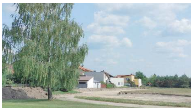
Trwa budowa nowych boisk przy ZSBiO w Biłgoraju
