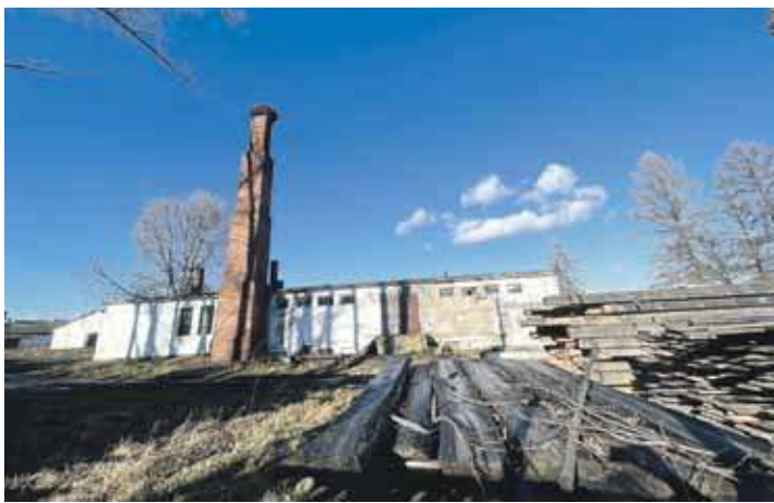
W tym miejscu ma powstać biogazownia.
