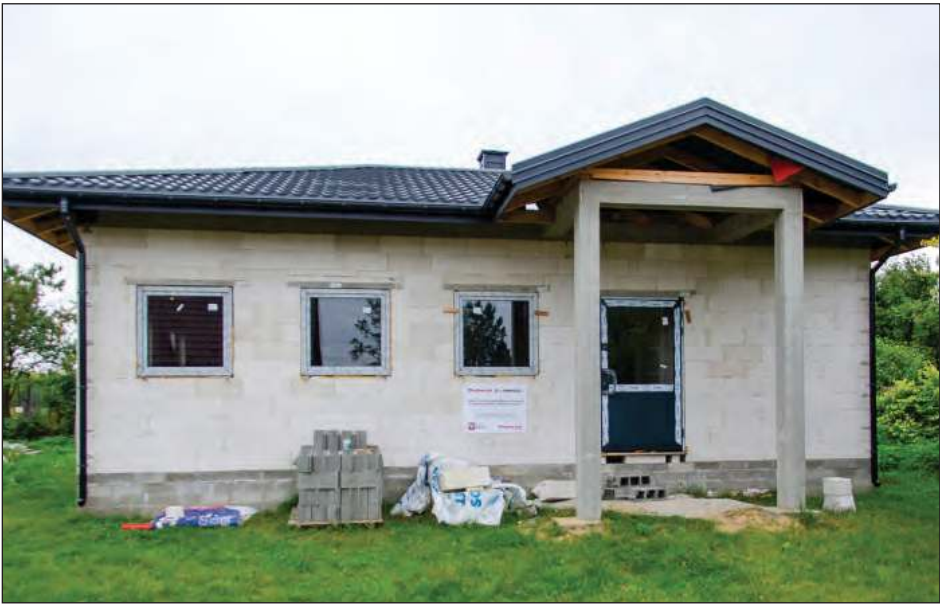
➤ Jedno z zadań objęło zakup oraz montaż stolarki okiennej i drzwiowej w świetlicy wiejskiej w Nowym Pilczynie
