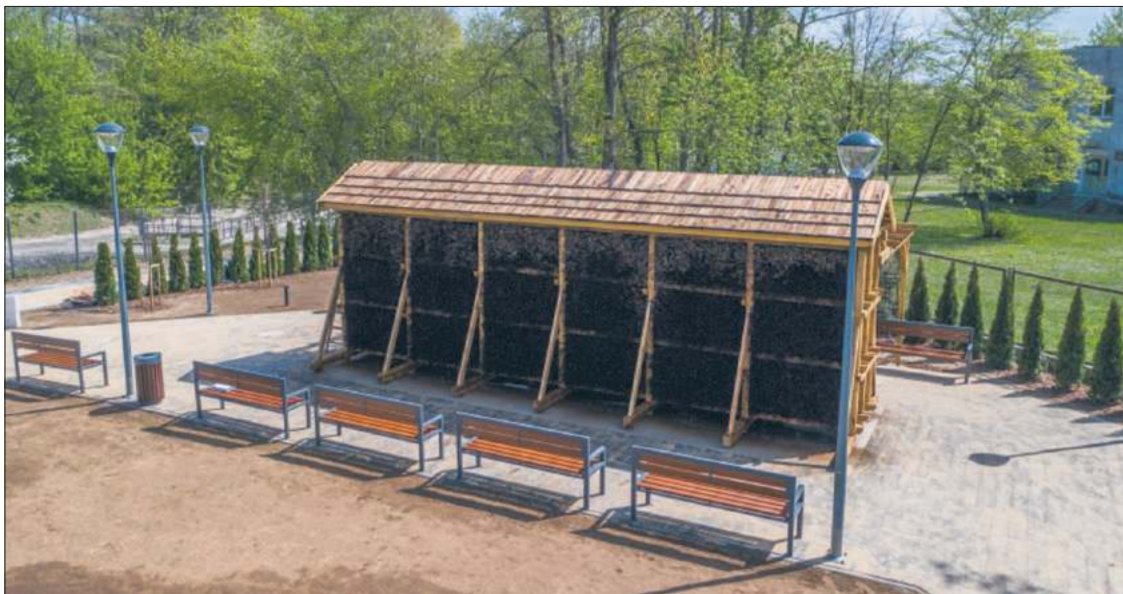
Tężnia solankowa przy ul. Szpitalnej
