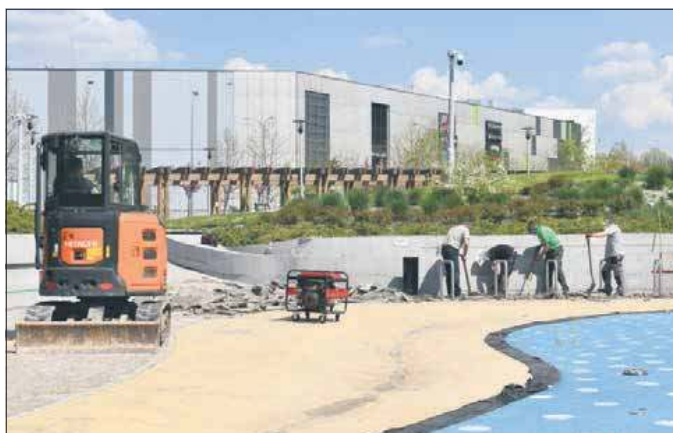
Prace remontowe już trwają
