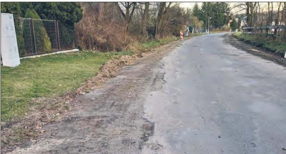
✚ Rozpoczął się pierwszy etap inwestycji wartej blisko 10 mln zł. Obecnie trwa przebudowa drogi powiatowej we Wrzosówce (gm. Nowodwór)
