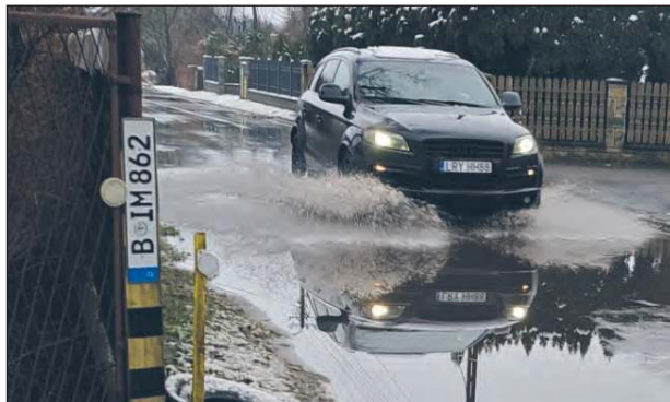
■ Mieszkańcy mieli nadzieję, że coś poprawi się po remoncie nawierzchni ulicy Franciszkańskiej. Nowy asfalt pojawił się 2 lata temu. Jezdnia zrobiła się gładka, ale woda wciąż nie odpływa
