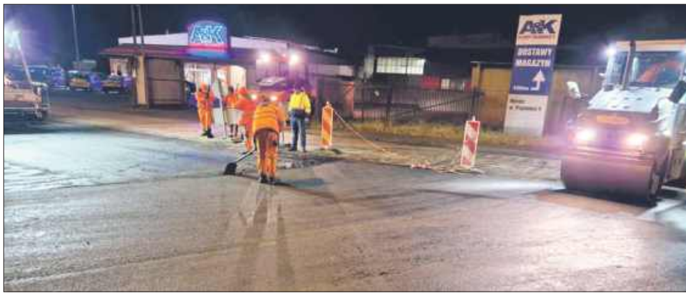
Prace nad łącznikiem ulic Korczaka i Piaskowej trwały nawet w nocy.
