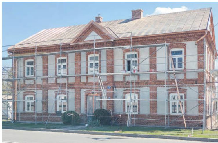
Wikariat w czasie remontu
