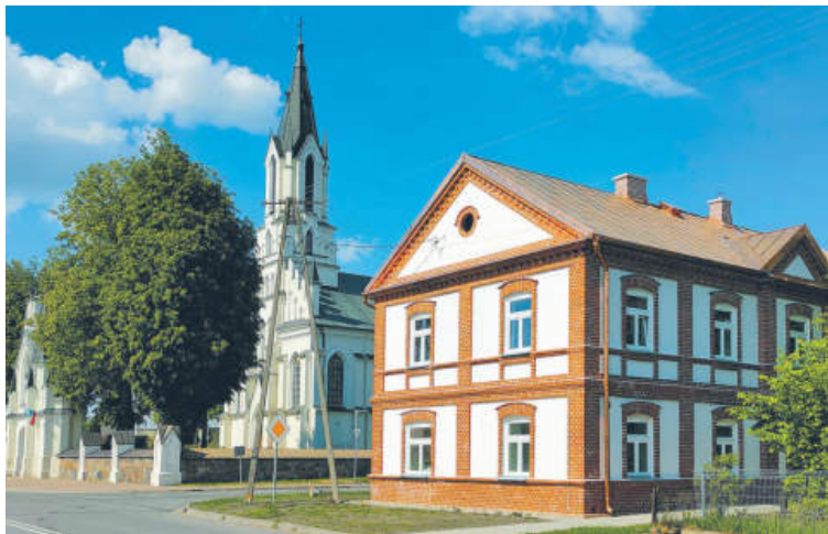
...i obecnie już po rozebraniu rusztowań
