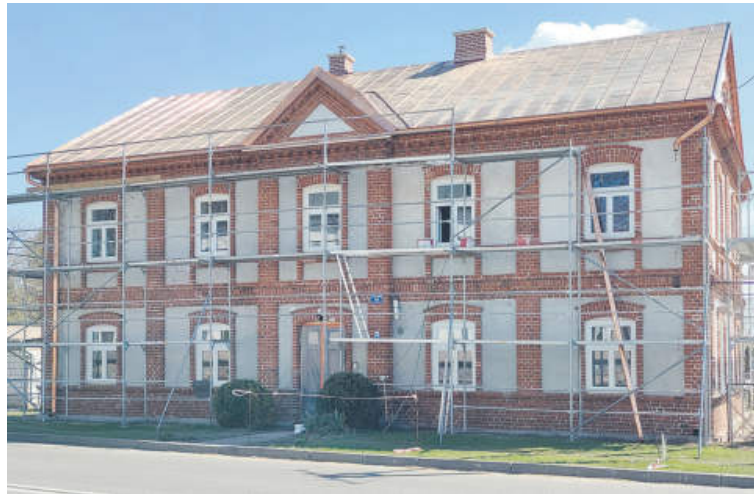
Wikariat w czasie remontu
