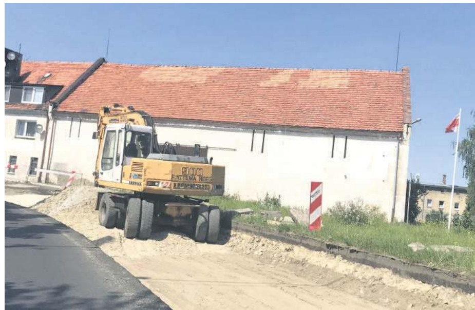
Maszyny pozostały na placu budowy w Ludowie Polskim, gdyż przebudowa drogi opóźniła się
