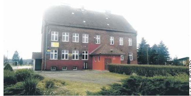
Publiczna Szkoła Podstawowa w Wójcicach. Od września formalnie będzie to dodatkowy budynek PSP w Minkowicach Oławskich
