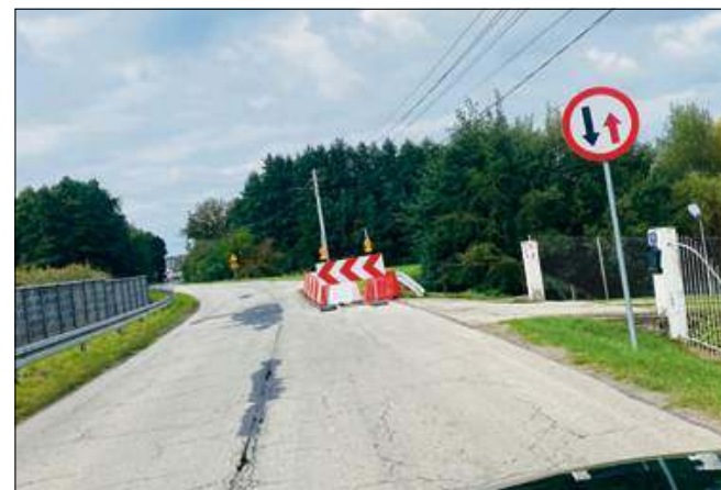
Przewężenia są dokładnie na łukach drogi, co powoduje, że nie widać, czy ktoś nie nadjeżdża z naprzeciwka.
