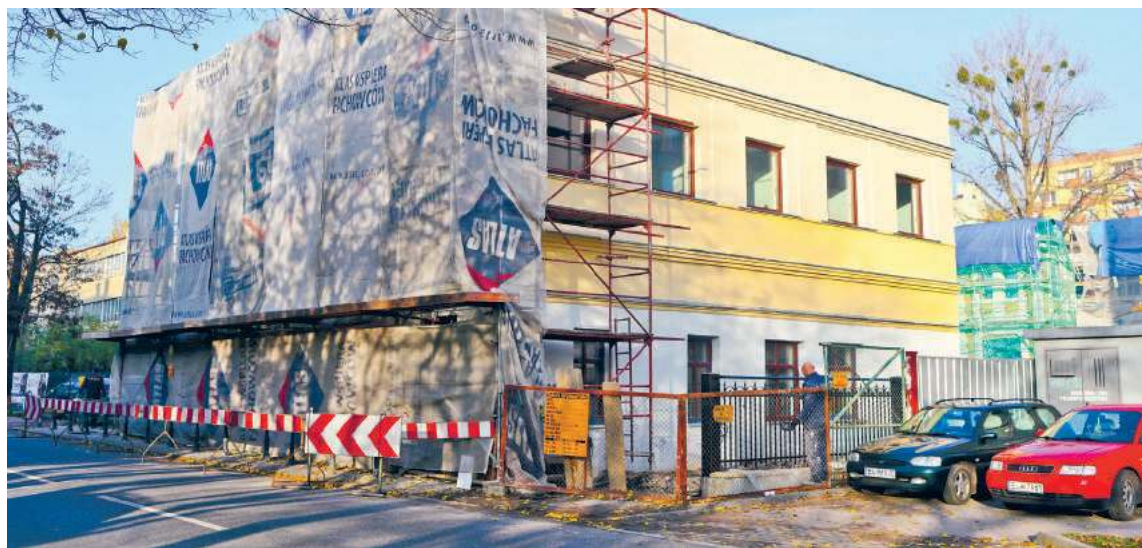
Budowa domu wielopokoleniowego kosztowała już ponad 8 mln zł | fot. Jan Środa/Gazeta Polska
