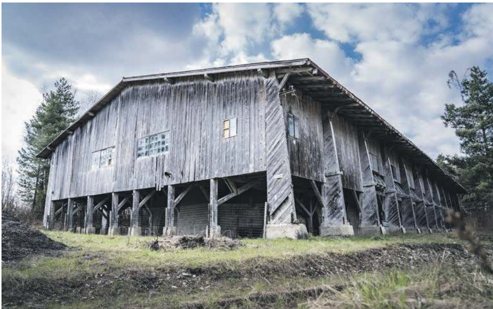
Wybudowana w 1949 roku drewniana konstrukcja okalająca piec
