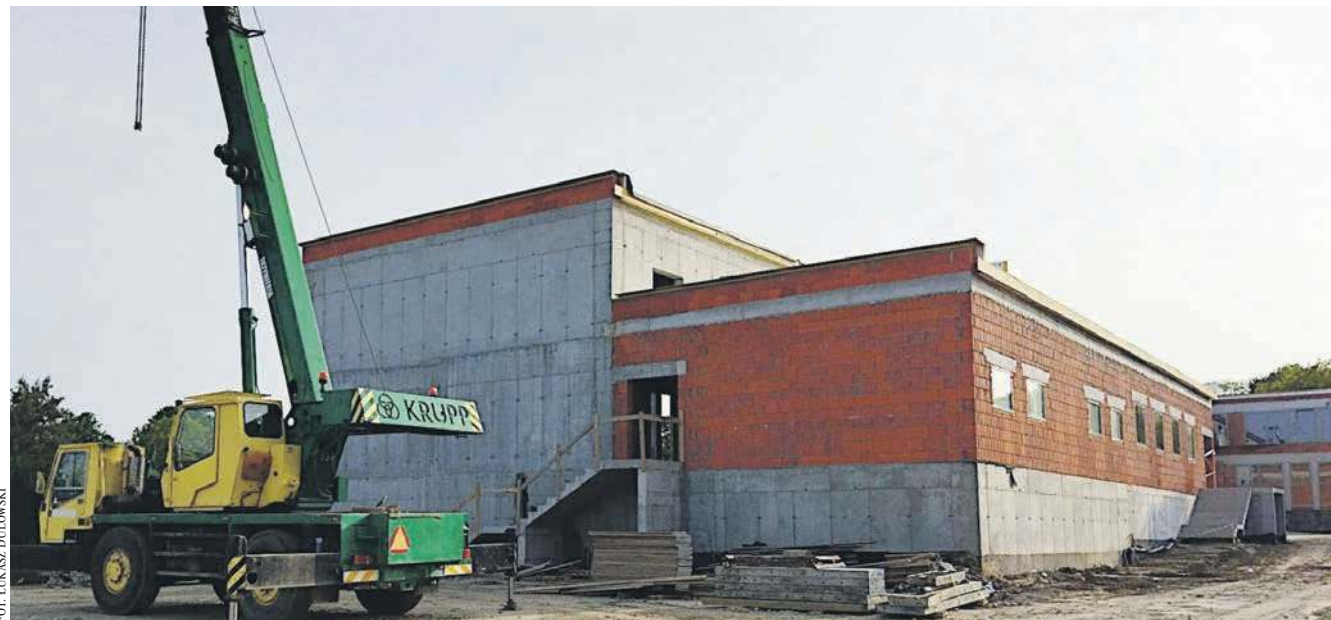
Sala gimnastyczna dobudowana do SP nr 6 w Kościelcu
