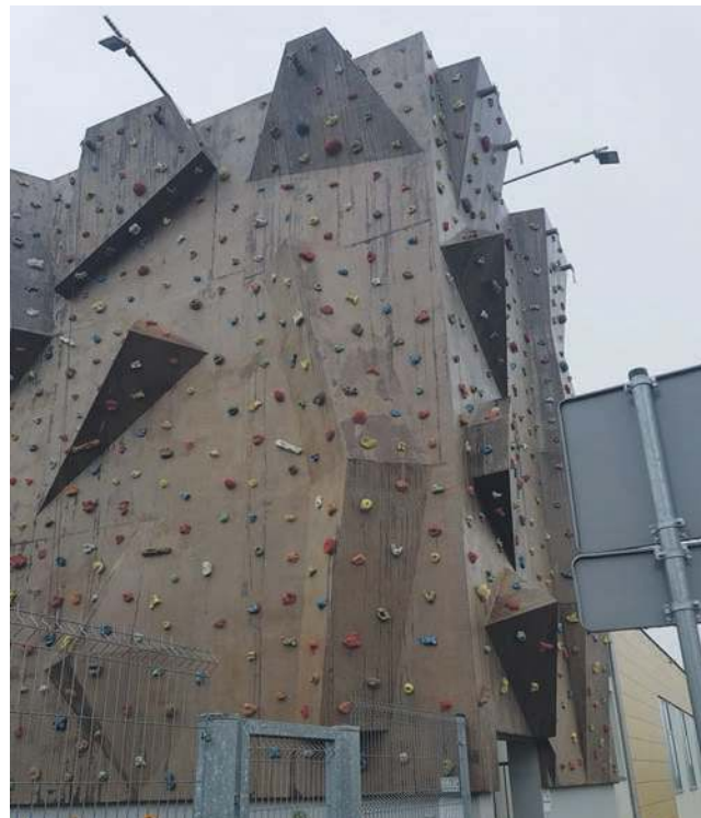
Nieczynna od roku ścianka wspinaczkowa przy basenie w Libiążu
