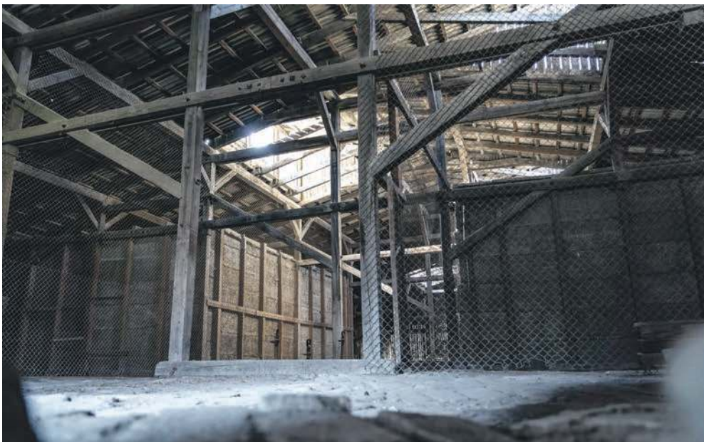
Wnętrze górnej kondygnacji znajdującej się nad właściwym piecem
