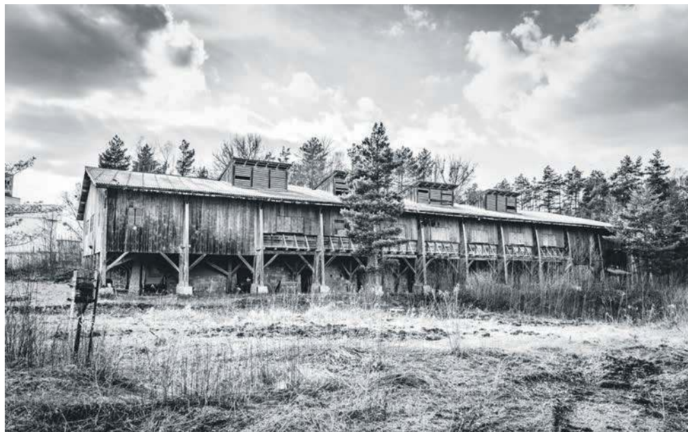
Konstrukcja robi ogromne wrażenie, zarówno pod względem wielkości, jak również rozwiązań technicznych
