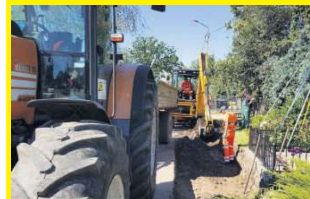
Chodnik w Czerwieńcu wykonują pracownicy Powiatowego Zarządu Dróg w Strzelinie (Foto: Sołectwo Czerwieniec)
