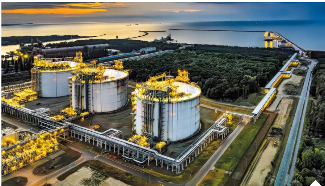
Terminal LNG im. Lecha Kaczyńskiego w Świnoujściu | fot. mat. pras./d
