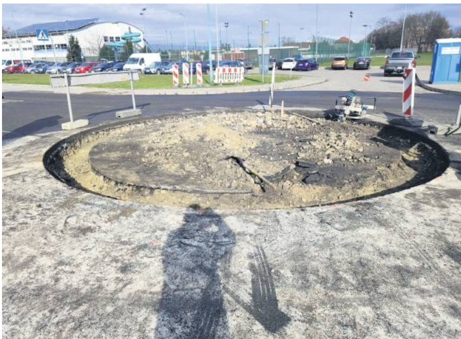
Trwają prace przy przebudowie ronda obok targowiska
