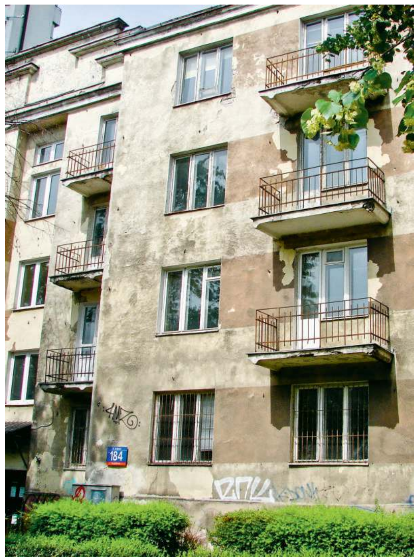
Niszcząca kamienica przy ul. Grójeckiej 184 i fragment balustrady jej balkonu z prętami wygiętymi o
