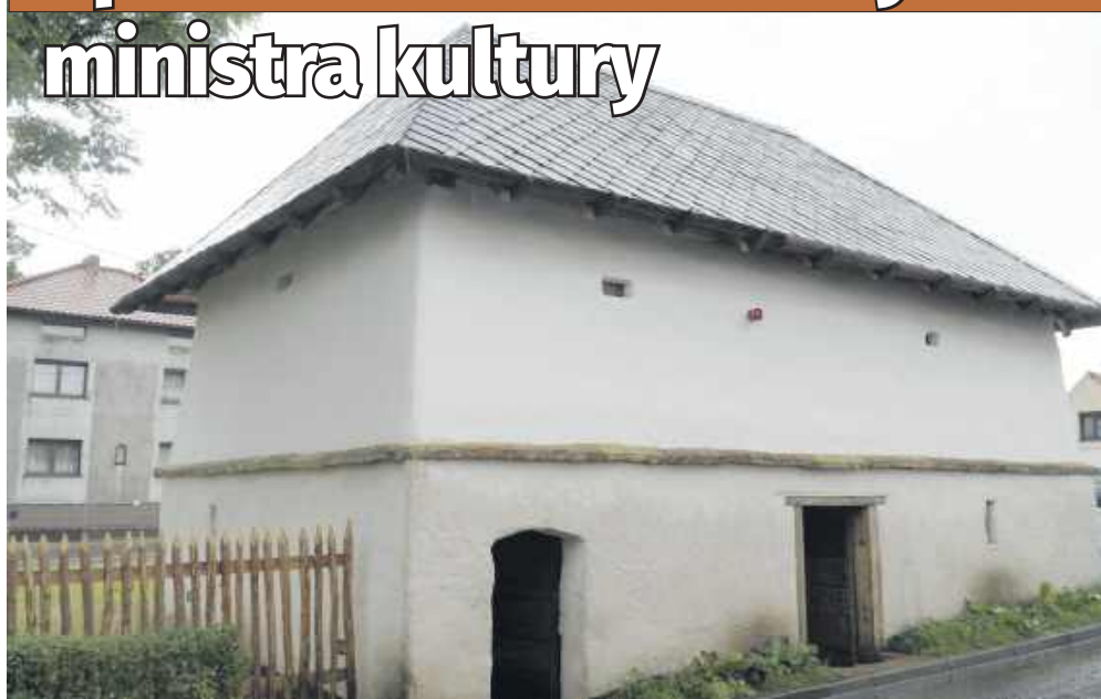
■ Zakończony remont przywrócił spichlerzowi trwałość konstrukcyjną
