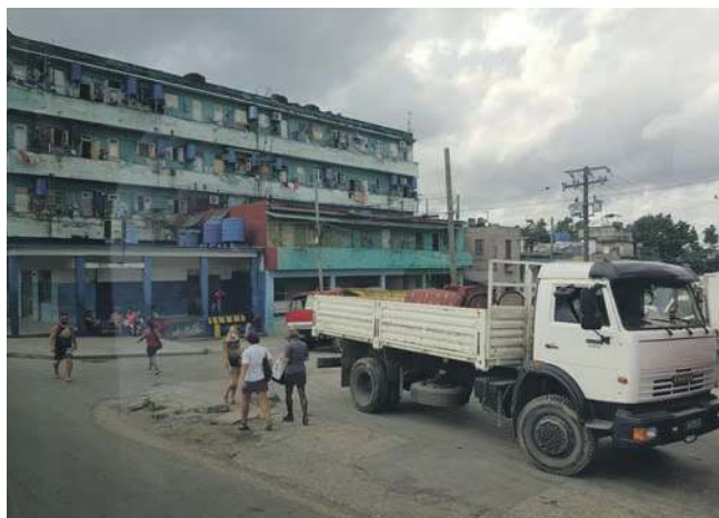
Bloki mieszkalne, podobnie jak większość domków jednorodzinnych są bardzo zaniedbane
