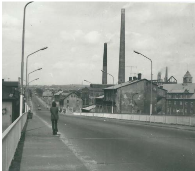
Wiadukt w Trzebini po otwarciu w 1972 r.
