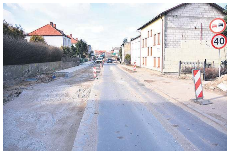
W czasie remontu DW 240 na opisywanym fragmencie roboty były bardzo zaawansowane. Wymieniano nawet podbudowę drogi.
